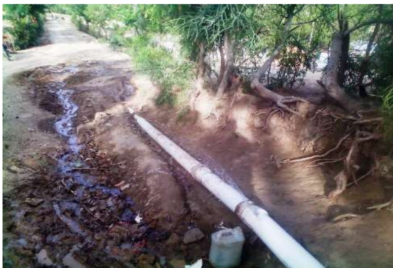
Photo 4: Fuites sur la ligne d'adduction du réseau de Jean Rabel
