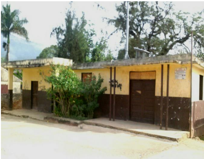
Mairie de Moron Photo: D. Ralph
