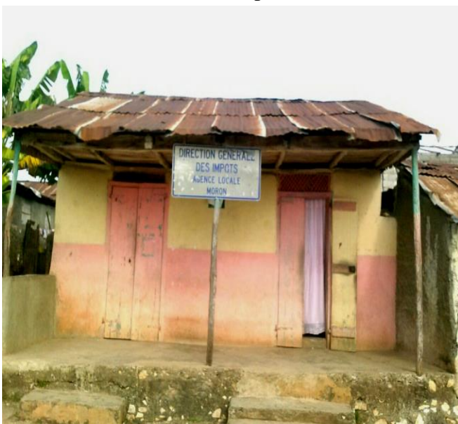
Direction Générale des Impôts Photo : D. Ralph
