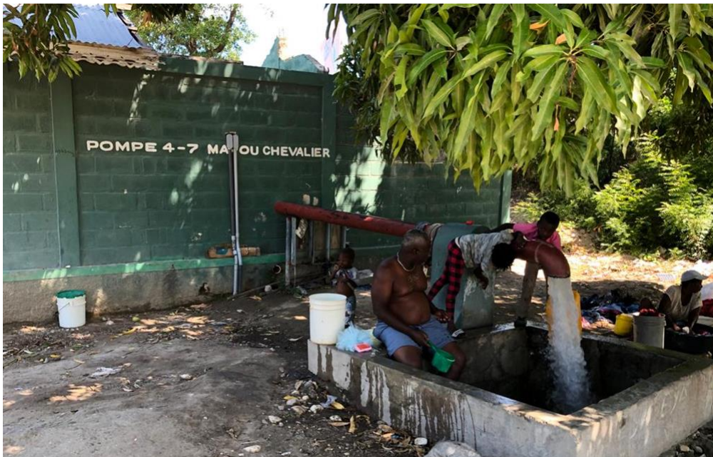
Figure 19: Utilisation d'un déversoir pour des services domestiques
